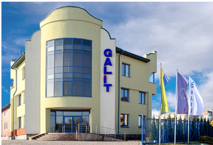
Офисное здание предприятия «Галит»
